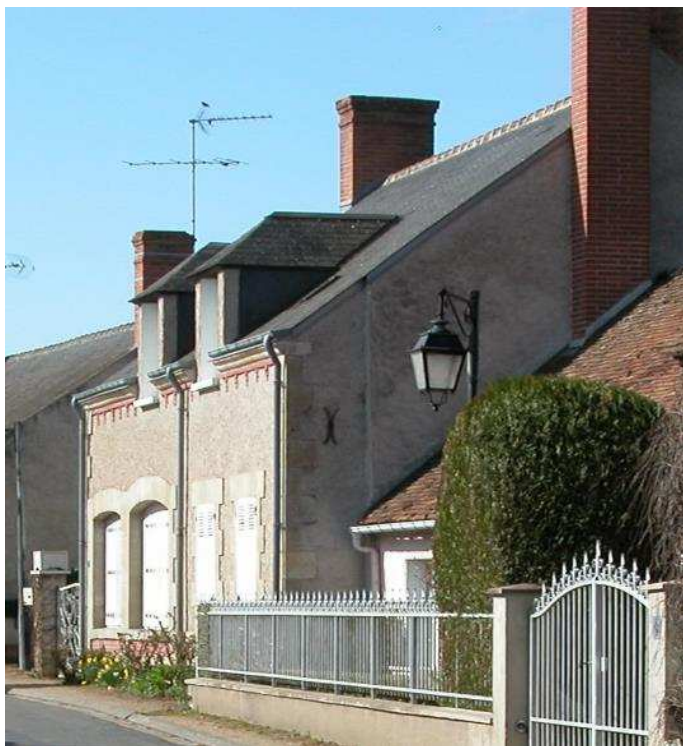
Toitures en ardoises, lucarnes pendantes, façade enduite, éléments de décor (encadrement, chaîne d'angle...) en pierre, entablement et cheminées en briques
