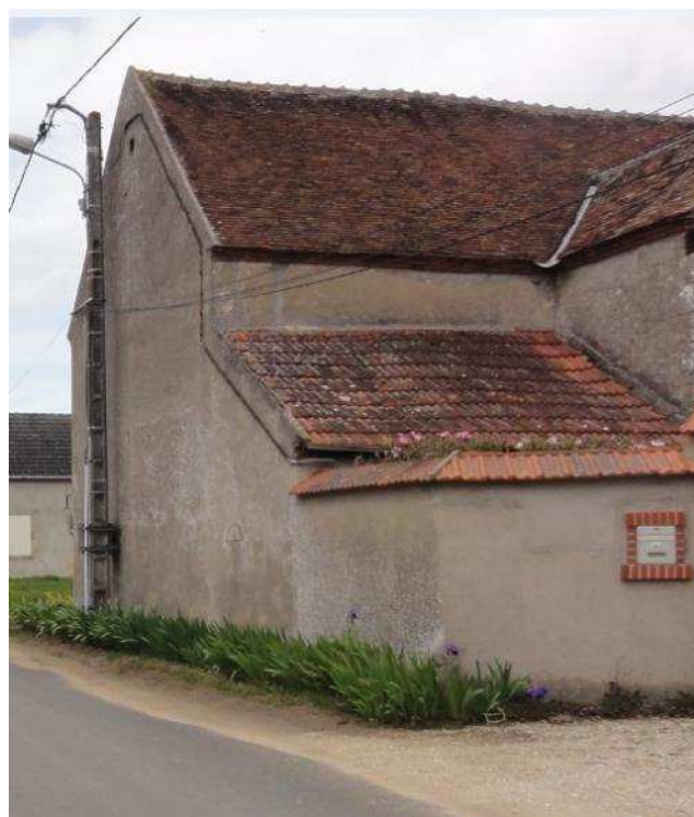
Toitures en tuiles sur le Mesnil.
